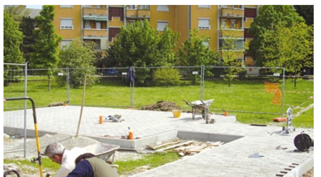
M.B. Lavori in via Tortini per realizzare la nuova "Casa dell'acqua" che verrà inaugurata e messa in servizio nel mese di giugno
